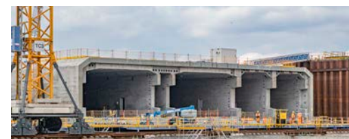
Ett av elementen till kommande Fehmarn Bält-tunneln
